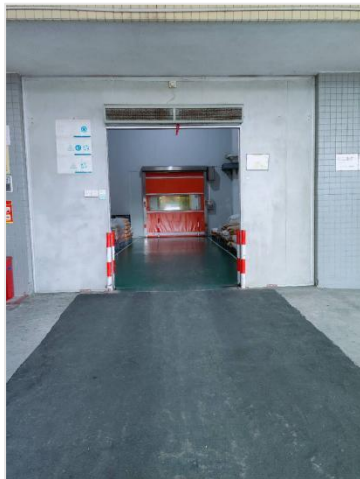
车间设置无障碍坡道
