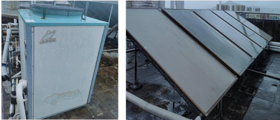
公司宿舍使用的空气能、太阳能热水器
